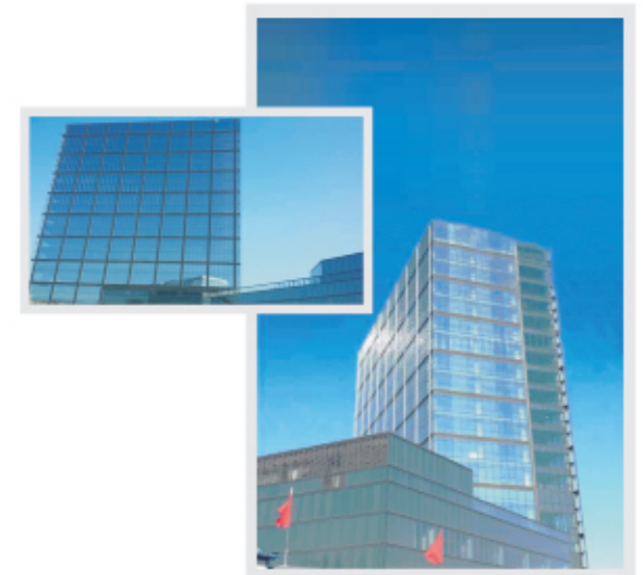
北京默沙东时代凌宇阳光国际新城 8mm Planibel™ G+12Ar+8mm Stopsol® 8mm Sunergy® A Clear +12Ar+8mm Planibel™ G
