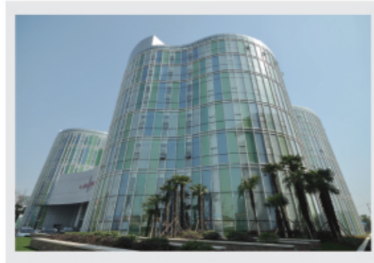
无锡家居设计创意园 6mm Planibel™ G+12A+12mm 白玻 彩釉 6mm Planibel™ G+12A+10mm 白玻 彩釉 28,000M 2
